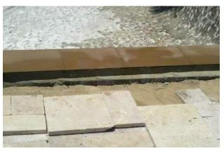
SEALING W/ AQUAMIX PENITRATING SEALER IS HIGHLY RECOMMENDED AFTER GROUT IS APPLIED
